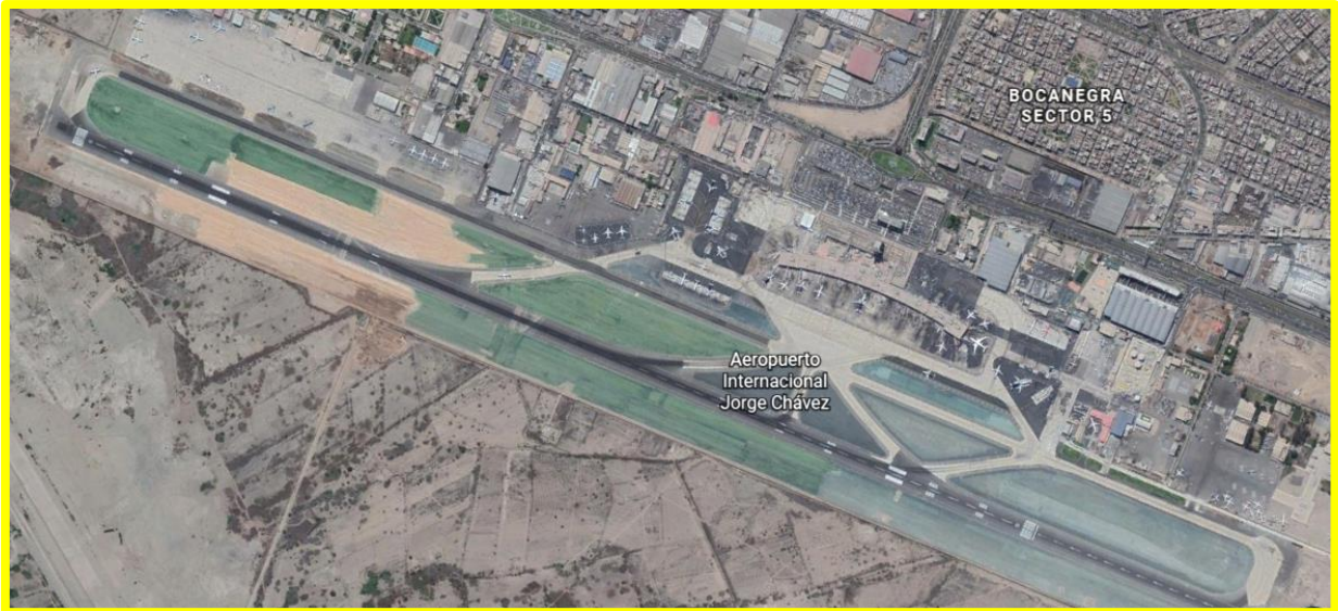
Figura 1 Vista actual del Aeropuerto Internacional Jorge Chávez
