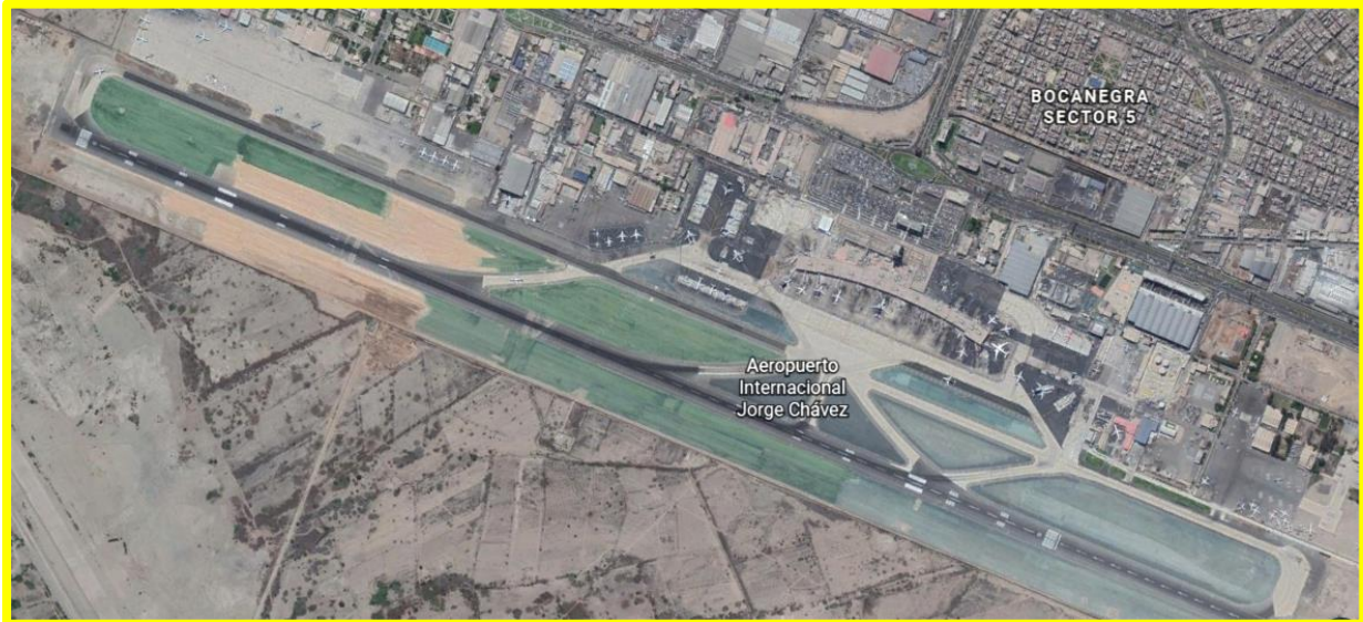
Figura 23. Pista de despegue y aterrizaje del Aeropuerto Internacional Jorge Chávez (GRUP8)
